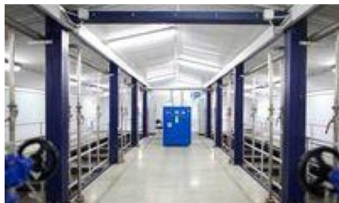
Для с. Пологое Займище рекомендуется блочно-модульная станция ЁРШ-Б модели Е-200Б производительностью до 200 м<sup>3</sup>/сутки. Габаритные размеры станции модели Е-200Б - (Д\*Ш\*В) 12\*6\*5,6 метра, по бетонному основанию 14\*8 метров. Санитарно-защитная зона не превышает 50 метров, что допускает размещение её в населённом пункте непосредственно в границах обслуживаемых кварталов.
